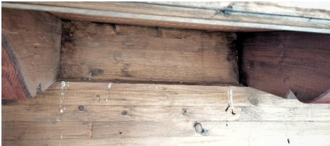
Fotos 2 y 3: situación bajo alero y hueco entre dos vigas.
