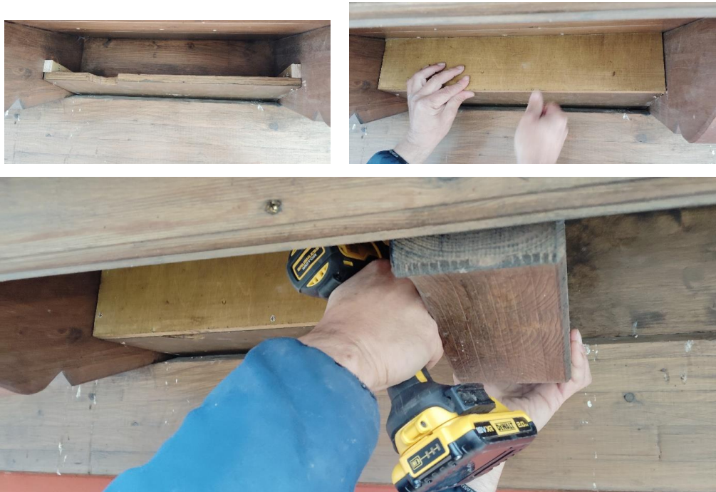
Fotos 3,4 y 5: proceso de construcción y colocación del nidal.
