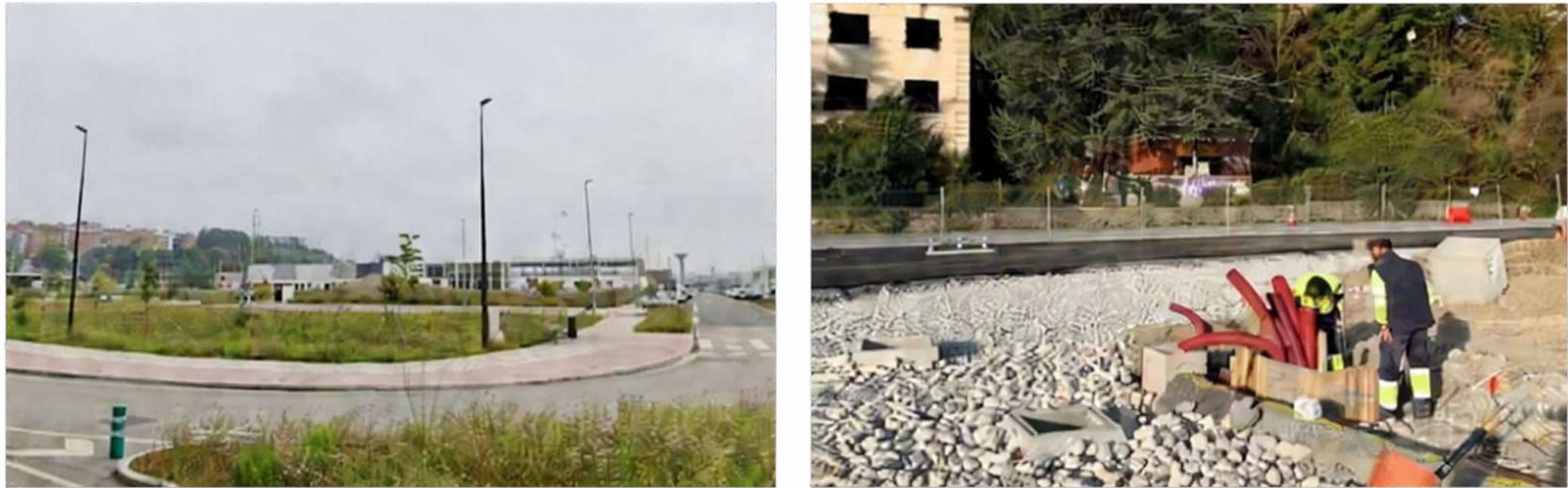
Ibarzaharra. Urbanización y construcción del sistema de drenaje sostenible.
