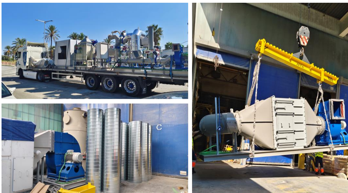
Figura 5. Conjunto de imágenes de la instalación del piloto LIFE ABATE en Ecoparc 3. Fuente: Elaboración propia, LIFE ABATE.
