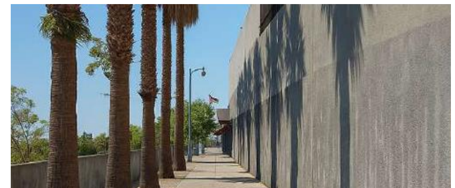
F16. EJEMPLO DE PAVIMENTO EXCESIVAMENTE IMPERMEABLE E INADECUADA ELECCIÓN DE ESPECIES
