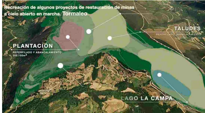
RESTAURACION CIELO ABIERTO (ASTURIAS)
