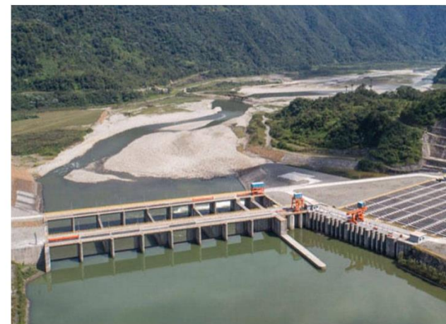
La central hidroeléctrica Coca Codo Sinclair que cubre el 30% de la demanda eléctrica de Ecuador. Corporación Eléctrica del Ecuador
