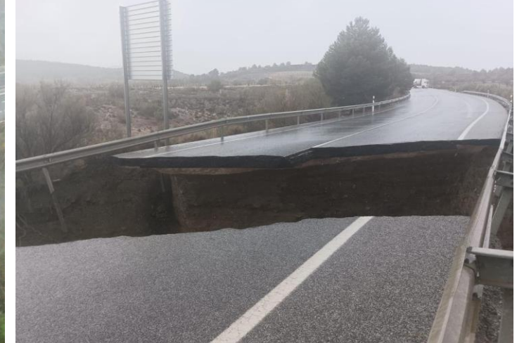
A-334 PK32 (Almería) Noviembre 2024
