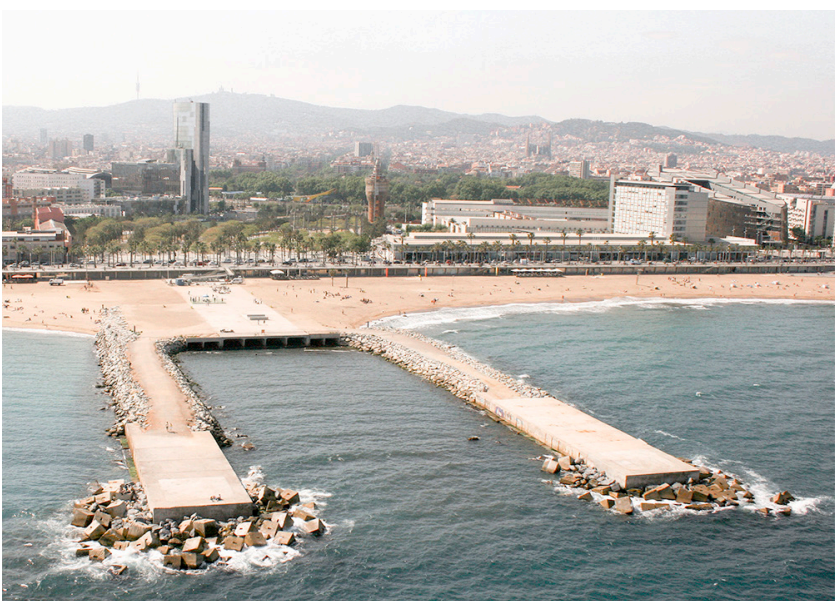
Fig. 114 Espigó del Gas. Barcelona, Catalunya. Fotografia de Javier Ortega
