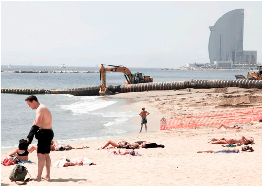
Fig. 107 Reposició de sorra a través de canonades a la platja de la Barceloneta, 2010. Barcelona, Catalunya. Fotografia d'A. Puig
