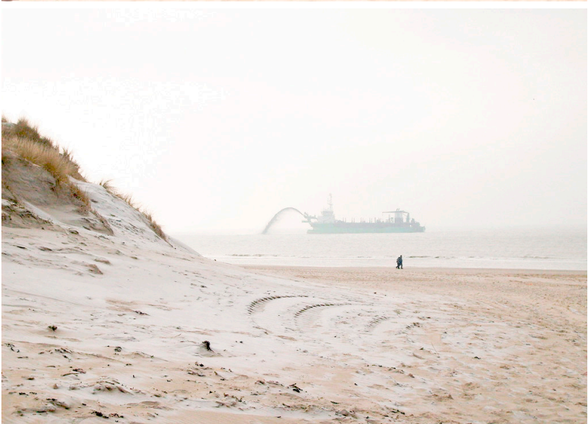
Fig. 108 Alimentació de sorra mitjançant una embarcació a la costa de Rotterdam. Rotterdam, Països Baixos. Fotografia de Tacowitte
