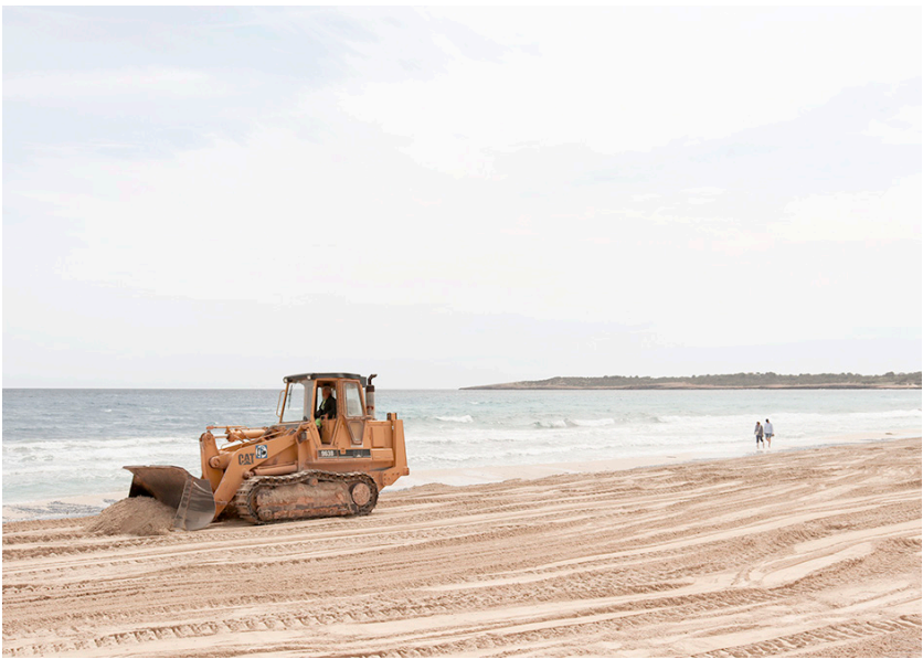
Fig. 106 Alimentació de sediments a la platja de Cala Millor. Cala Millor, Mallorca. Fotografia pròpia
