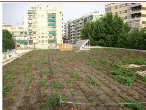
Figura 44. Cubierta vegetada en la azotea del colegio Gonzalbes Vera en el municipio de Xàtiva (Valencia). Proyecto AQUAVAL. Fuente: Imagen cedida por PMEnginyeria.
