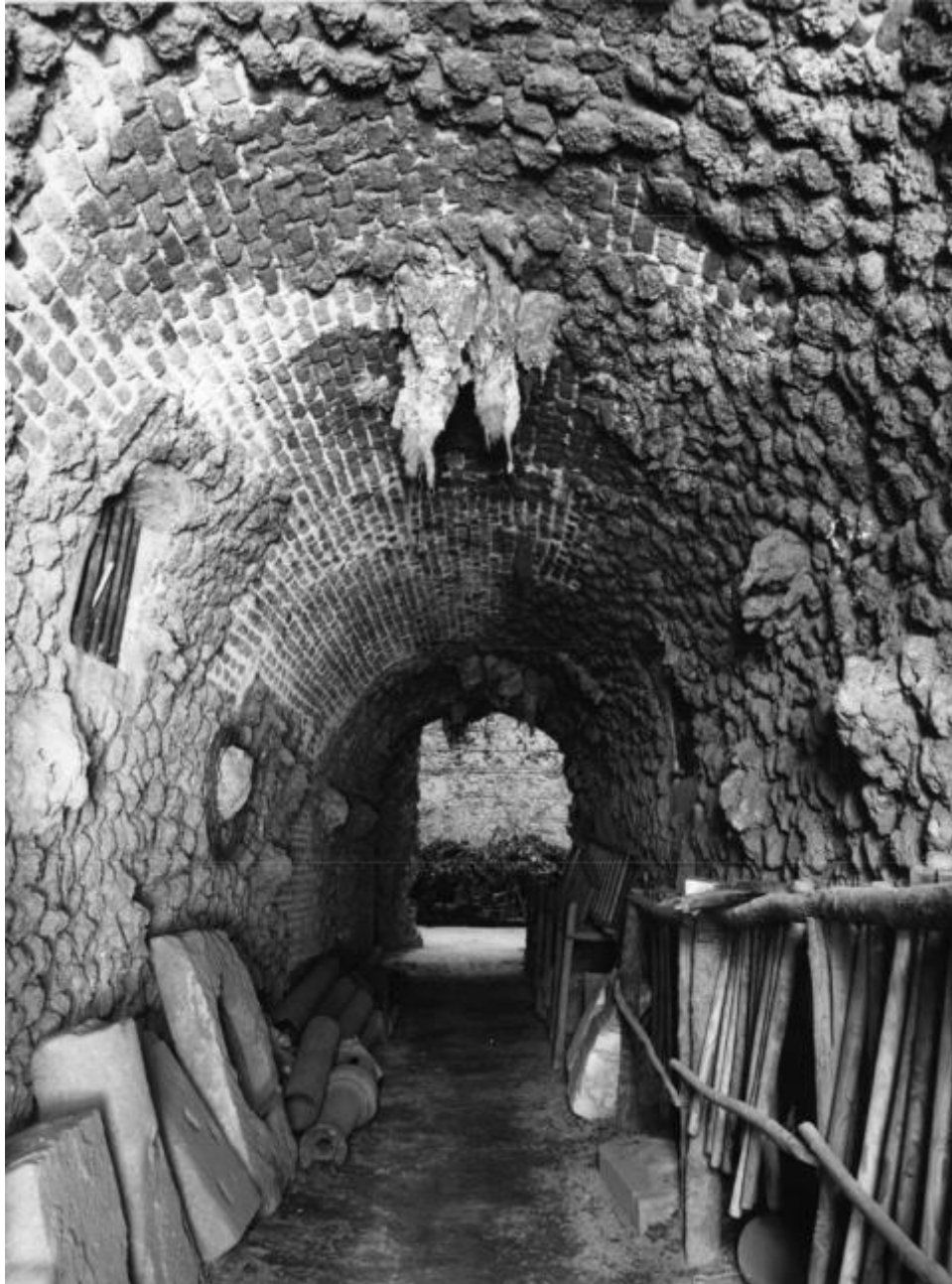
INTRADÓS DE UNA DE LAS BÓVEDAS DE LA MONTAÑA ARTIFICIAL, CUBIERTO DE ROCALLA
