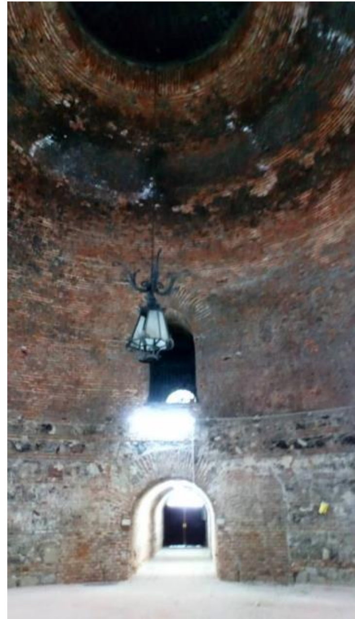
CÚPULA INTERIOR DE LA MONTAÑA ARTIFICIAL, EN CUYA CLAVE SE ABRE UN GRAN ÓCULO Y SE APOYA SOBRE UN BASAMENTO DE MURO MIXTO
