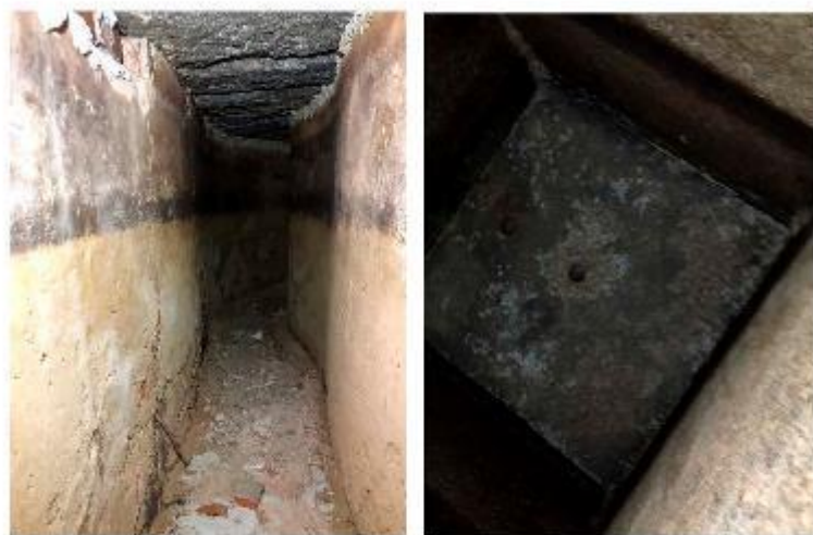
Vista de la canalización descubierta y tapa del pozo colector condenado en zona próxima a las escaleras de acceso a la galería.
