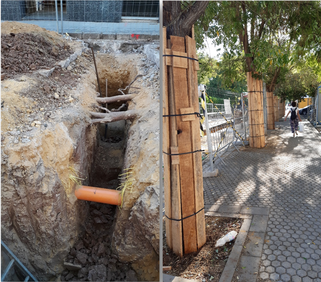
Figura 3. Detalle de distintas medidas de protección del arbolado en las obras: excavación manual en la zona de protección radicular y protección individual del tronco. (EMASESA)
