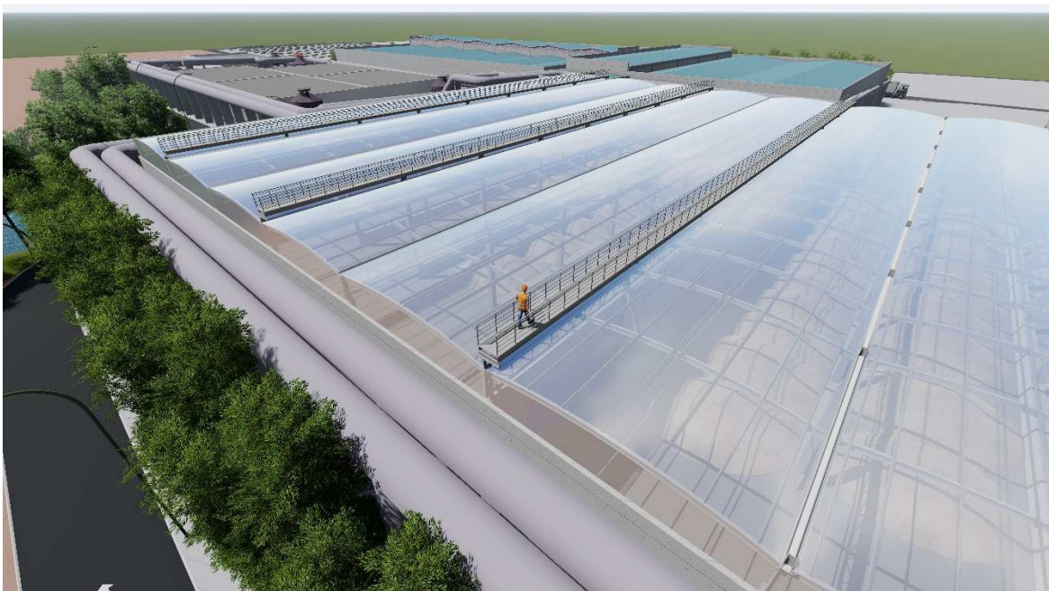
Foto 3: cubierta Nave de fermentación
