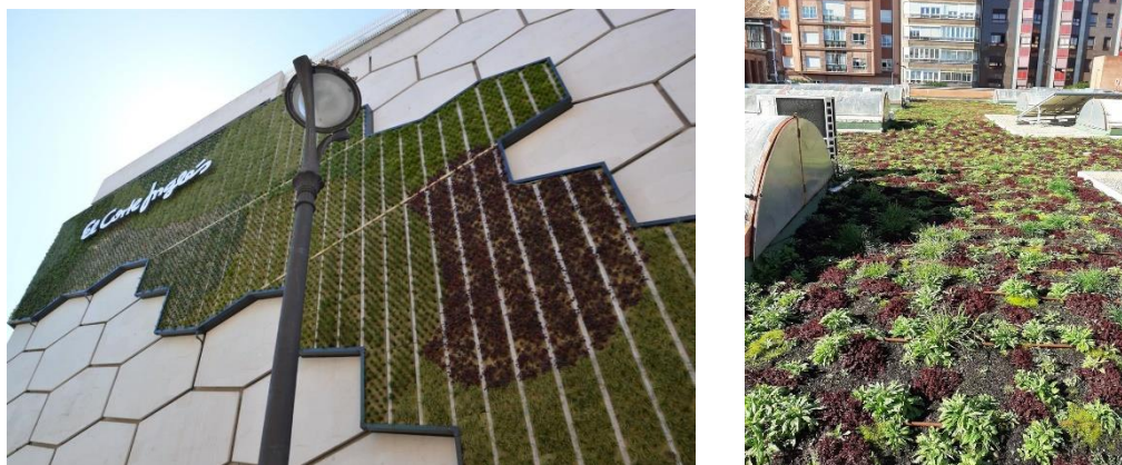
Figura 3. Fachada y cubierta verde instaladas en Valladolid. (Fuente: CARTIF)
