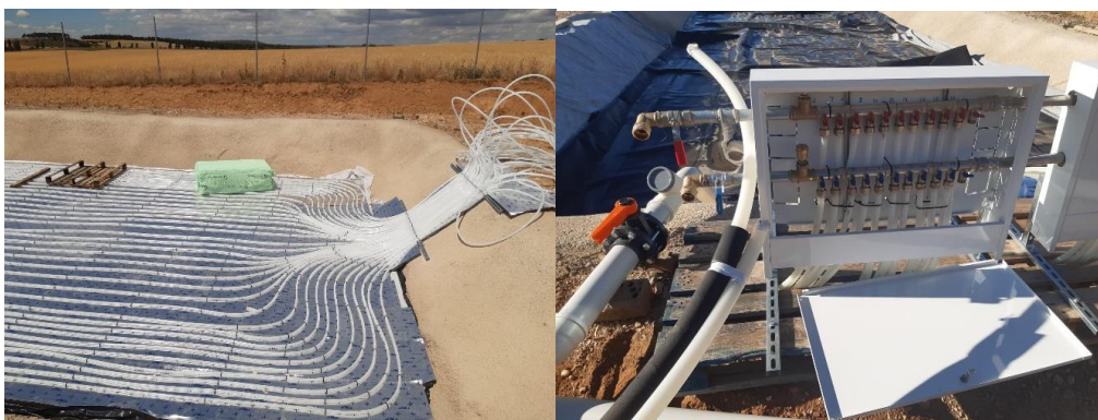
Figura 11. Suelo radiante digester anaerobio. Instalación y comprobación ausencia de fugas
