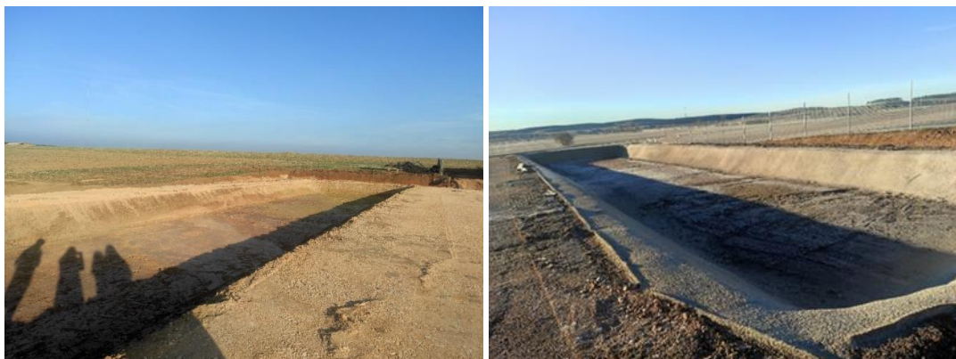
Figura 8. Zanja digestor anaerobio y gutinado
