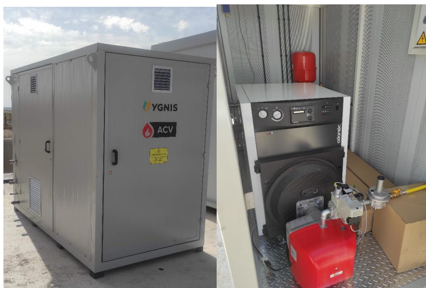
Figura 14. Caldera biogás P: 60 kW
