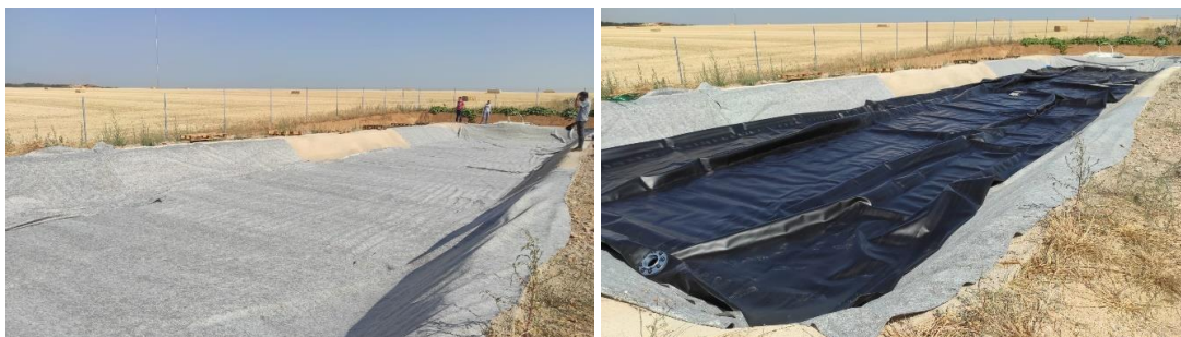
Figura 12. Instalación digester anaerobio: recubrimiento aislante textil sobre suelo radiante (izquierda) e instalación digester tipo bolsa (derecha)
