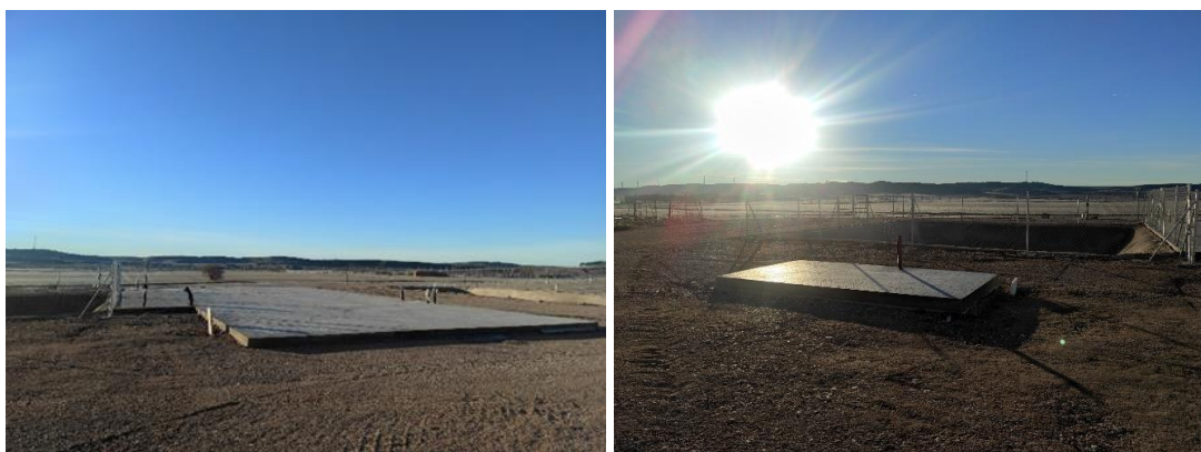
Figura 9. Zanja digestor anaerobio y gutinado
