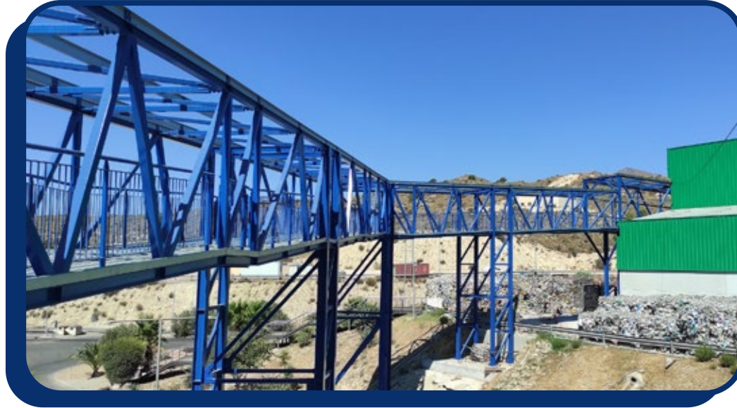
Ejecución terminada en enero de 2023
