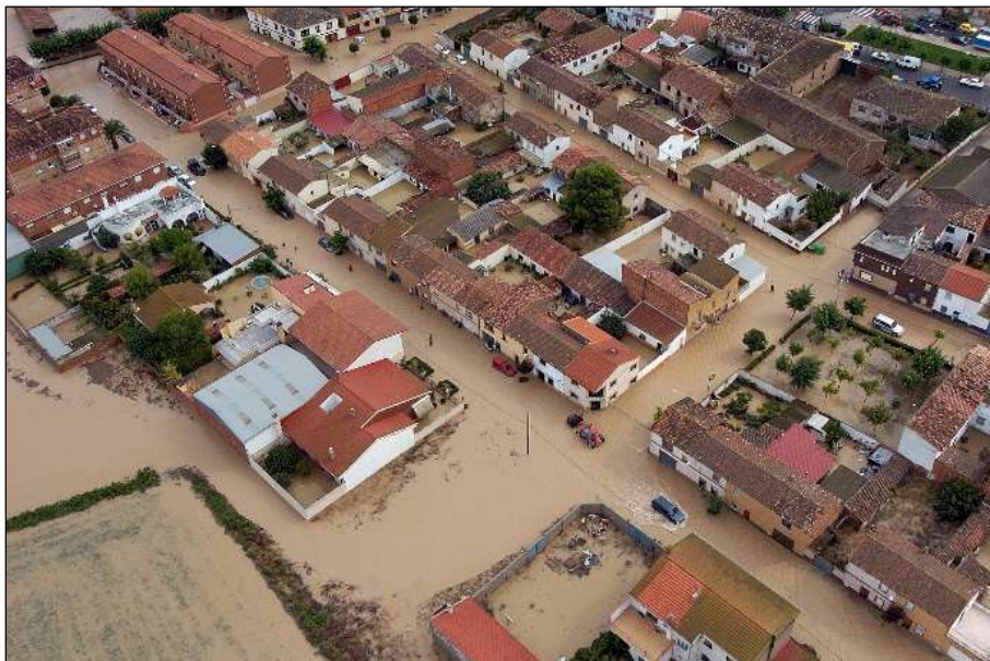
Figura 9. Importantes daños causados por el desbordamiento del río Huecha en Cortes en septiembre de 2004.
