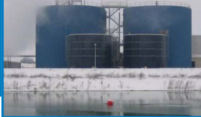
Digestores anaerobios en planta de secado de purines VAG (Juneda, Lleida)
