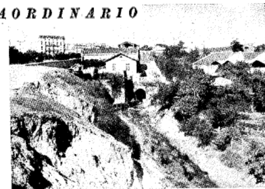
Desviación para el riego del colector de Méndez Alvaro en las inmediaciones de la estación de Atocha, en plena zona urbana.
