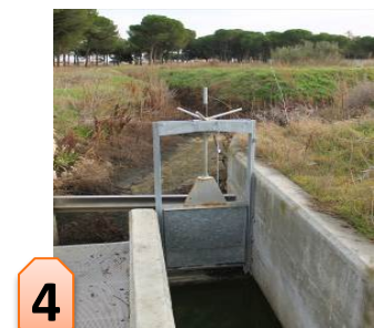
Punto de conexión
