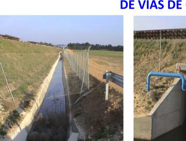
Empleo del talud de una carretera y de una vía del tren como trampa para la escorrentía. Los sedimentos son retenidos en cubetas de hormigón y el agua es conducida al canal de recarga artificial de la cubeta de Santiuste (Segovia)
