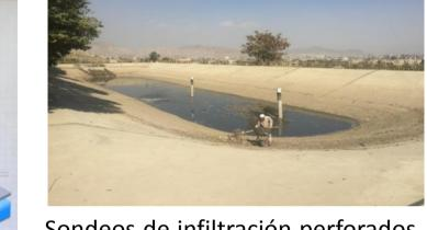
Sondeos de infiltración perforados en el interior de pozas de decantación e infiltración. Las inicialmente derivadas del río Helmand en situación excedentaria. Kabul, **AFGANISTÁN**, foto por cortesía de Landell & Mills
