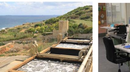
Barrera hidráulica positiva empleando las aguas de la depuradora de MALTA Sur. Reducción de la intrusión marina
