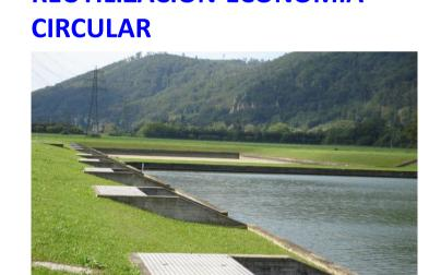
Balsas de infiltración con aguas regeneradas de la depuradora de Graz, AUSTRIA. Incremento reservas en torno a 3,5 hm<sup>3</sup>/año.
