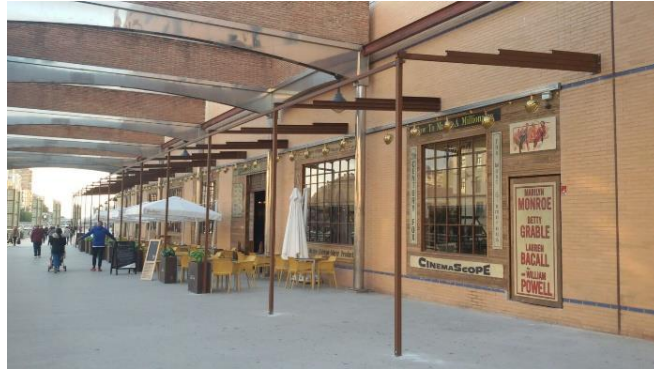
Figura 13 Pórticos principales de la estructura soporte
