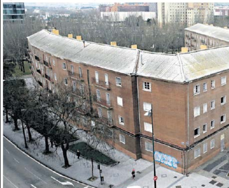
Bloque de viviendas (ocho portales) del antiguo cuartel de Puente Colgante, con accesos también en Reyes Católicos y Juan Sebastián Elcano.
