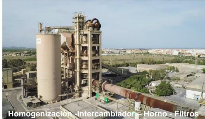
Homogenización - Intercambiador - Horno - Filtros
