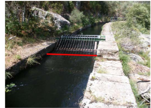
Alternativa para la ubicación de los transductores inmediatamente detrás de las rejillas de gruesos.
