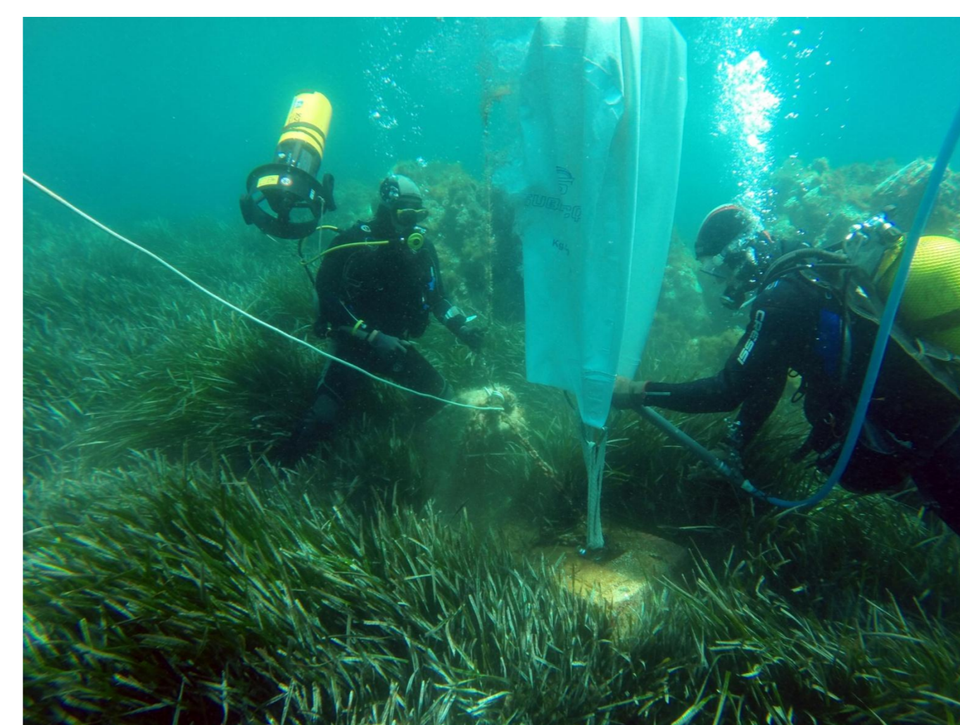
Figura 8: Maniobra de izado de un muerto de fondeo mediante el uso de un globo elevador.
