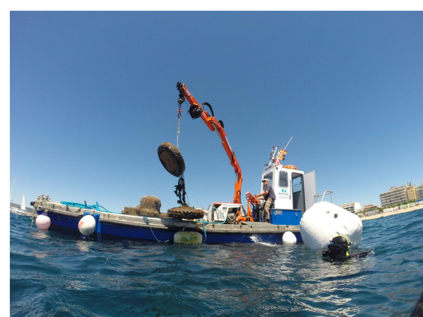
Figura 10: Extracción de los muertos de fondeo mediante el uso de un barco con grúa.
