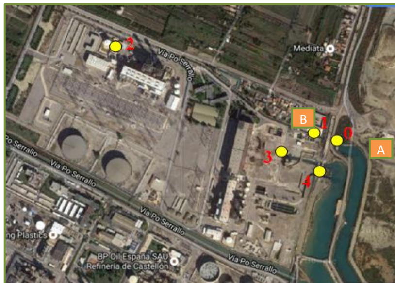
Figura 10: Disposición de los puntos de muestreo de pH a lo largo del circuito de refrigeración de la central durante las pruebas de inyección de CO2
