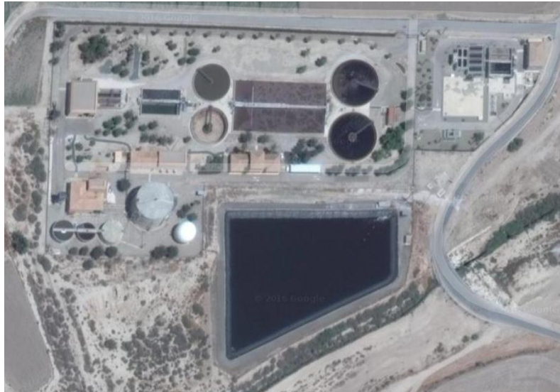
Figura 1. Vista aérea de EDAR La Hoya
