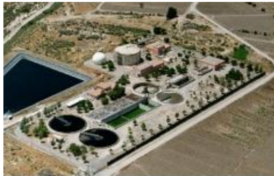
Figura 4. EDAR La Hoya.
