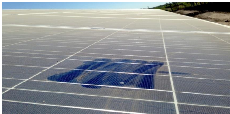
Fig. 2.3. Módulo cubierto de polvo. Fuente: Cadena y Montero (2007)..
