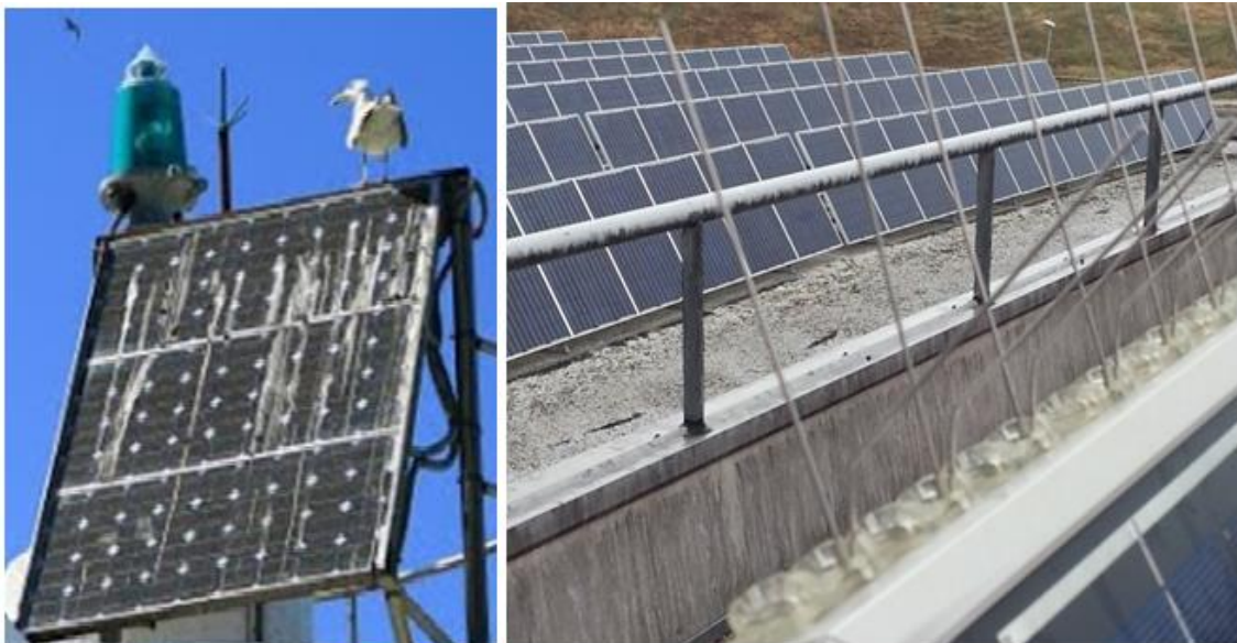
Fig.2.5. Módulos con excrementos y ahuyentadores de aves.
