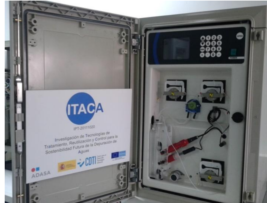
Analizador on-line (sin pretratamiento muestra)
