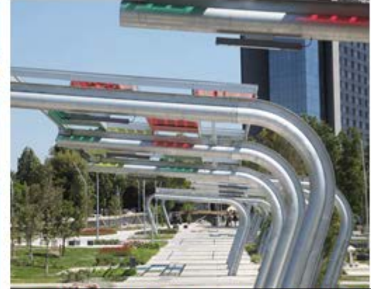
Instal·lació fotovoltaica Parc Can Rigalt
