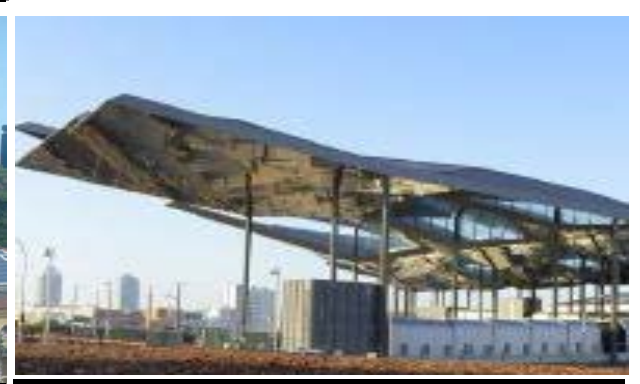
Cubierta fotovoltaica Encants
