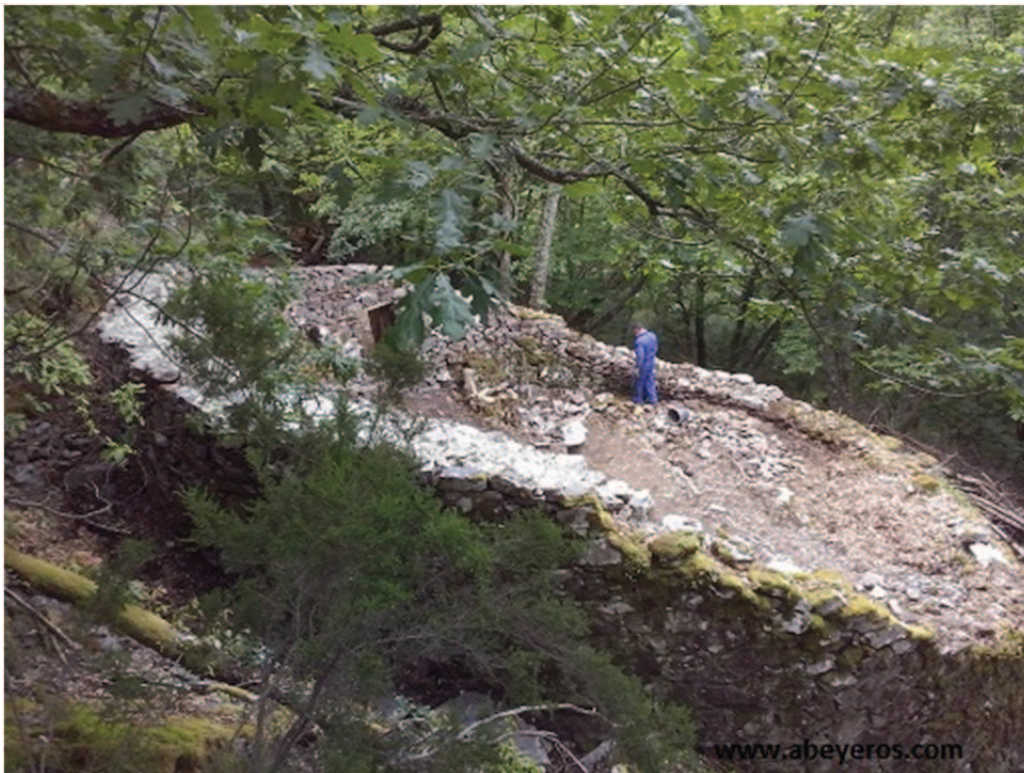
Restaurando la parte interior del muro del cortín
