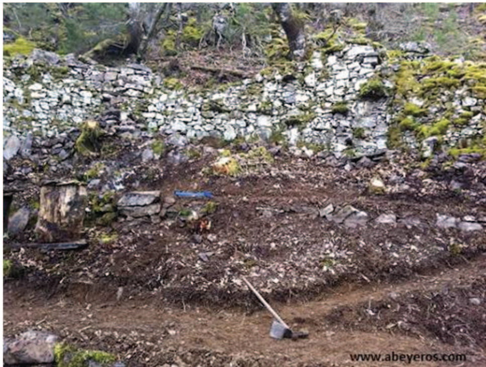
Acondicionamiento interior del cortín
