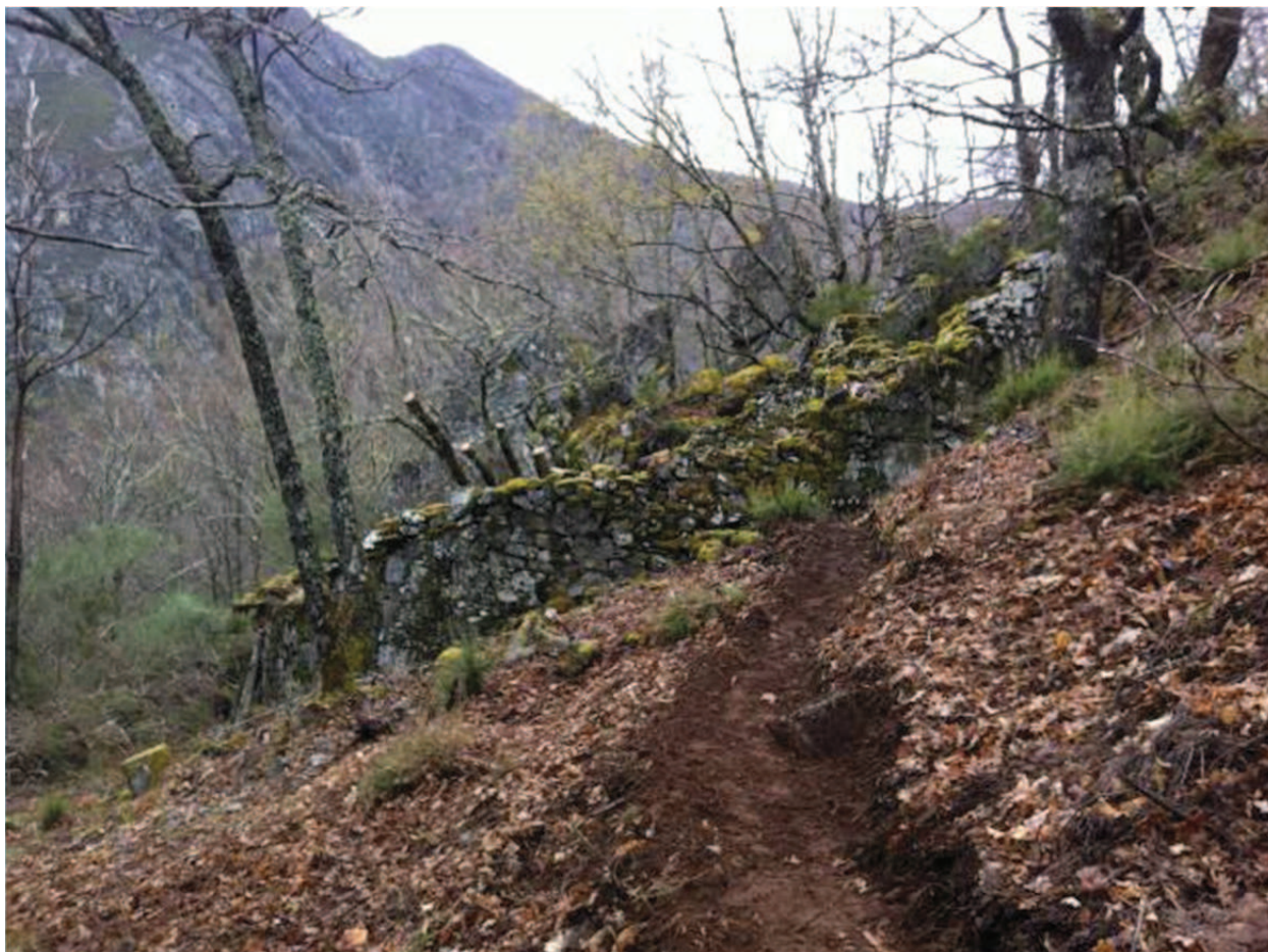
Vista del desbroce y construcción del camino
