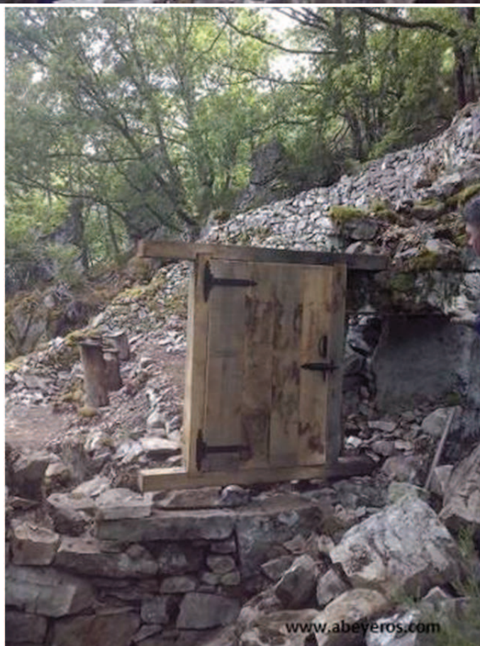
Apertura del hueco y colocación de la puerta
