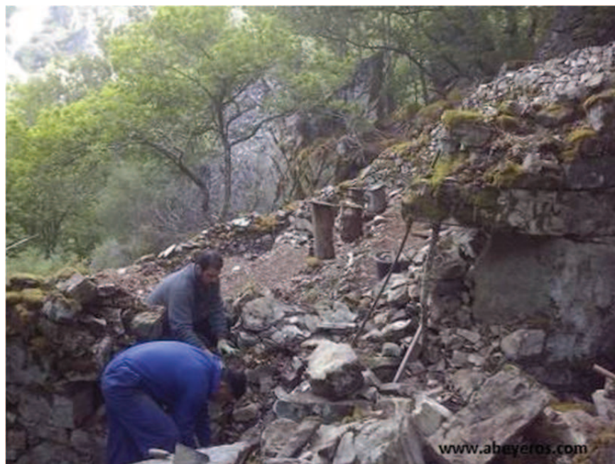
Dos momentos de la reconstrucción de la pared trasera, la más deteriorada
