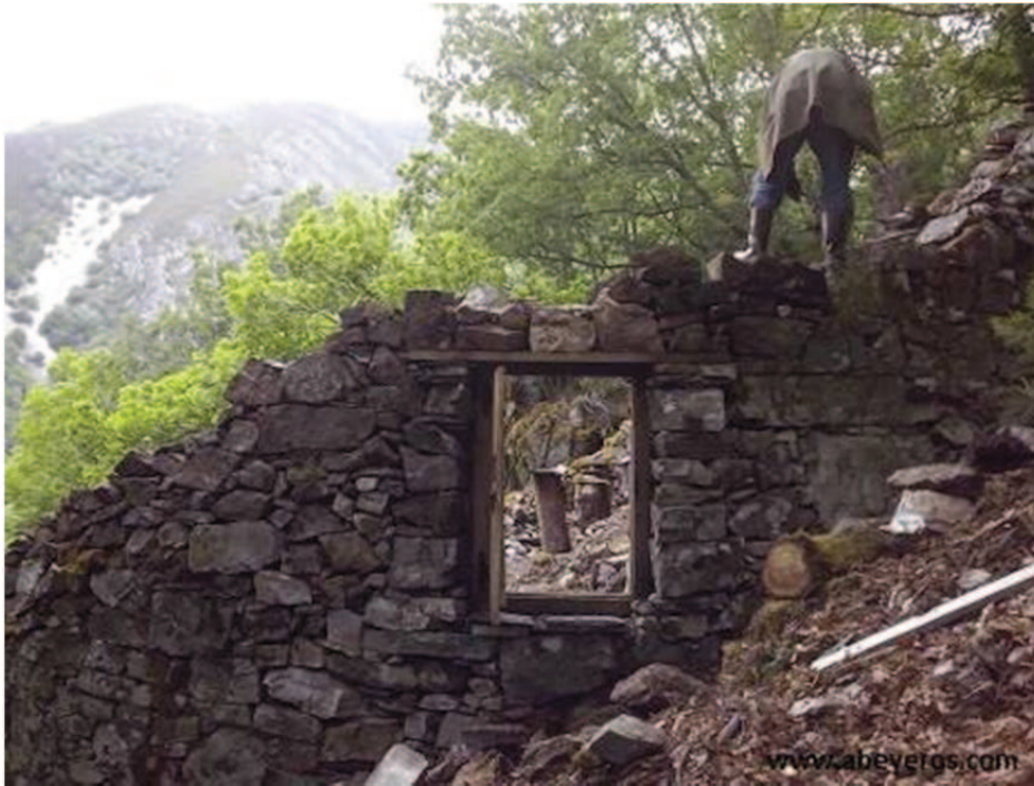
Reconstrucción del muro alrededor de la puerta
