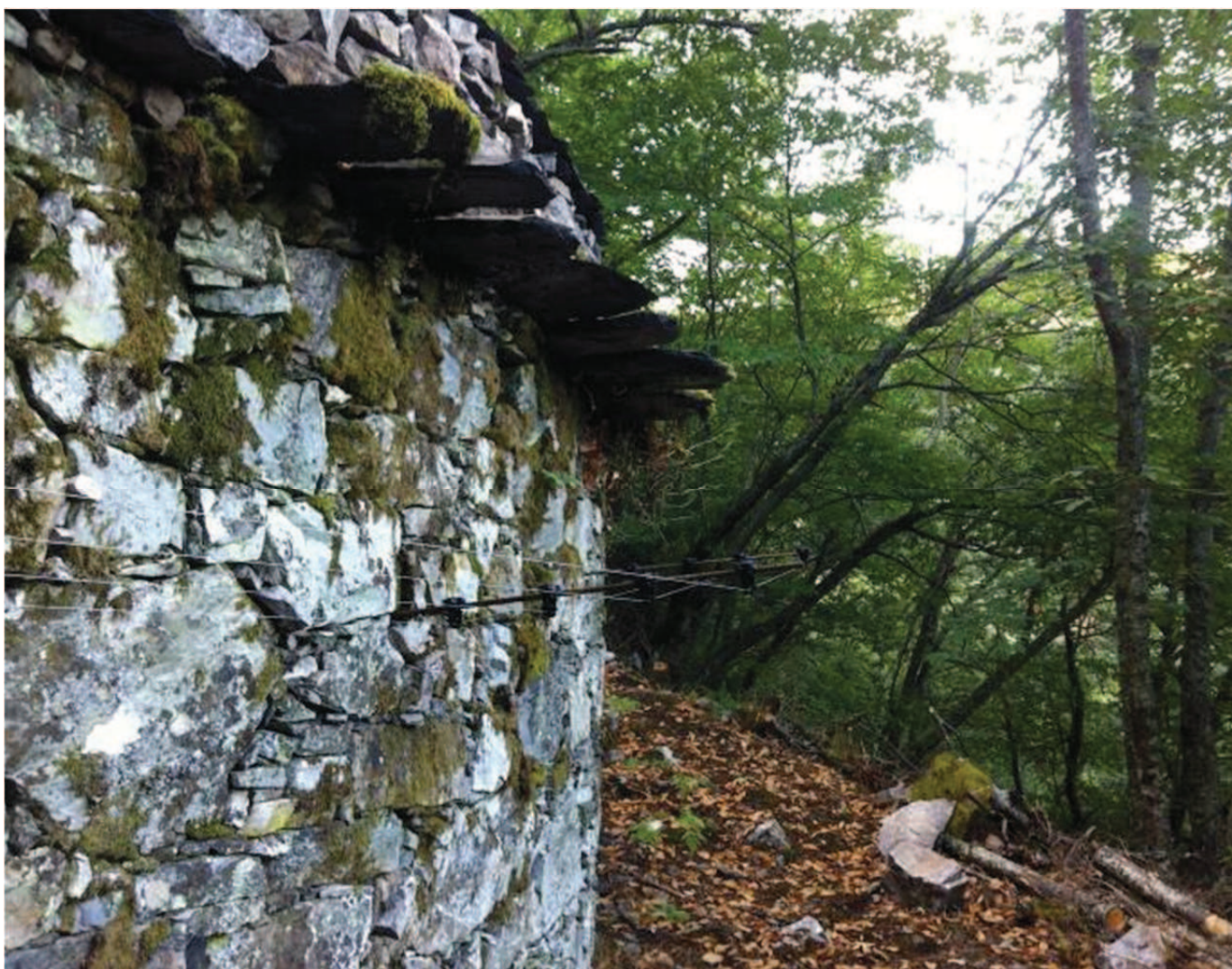
Colocación del pastor eléctrico por todo el perímetro
