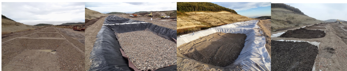
Fotos 8-11. Construcción de parcelas: estructura, impermeabilización y llenado de las celdas.
