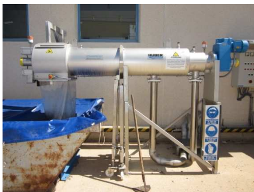
Figura 9. Instalación del tamizprensa.
