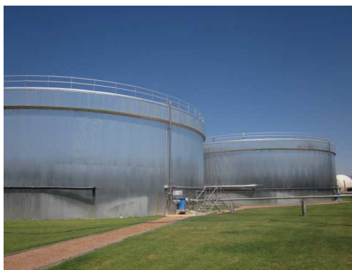
Figura 6. Digestores calorifugados.
