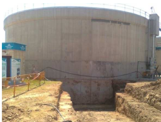
Figura 5. Actuación para realizar la limpieza de digestores.
