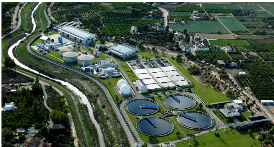
Figura 1. Vista aérea de la EDAR Murcia Este
