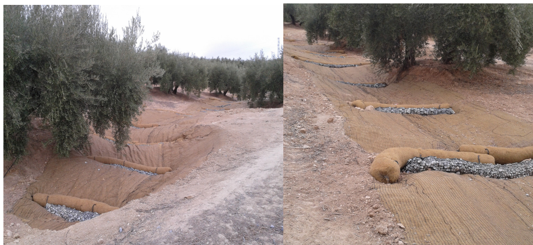
Figura 4. Ejemplo de biorrollos instalados en unas de las parcelas objeto de estudio.
