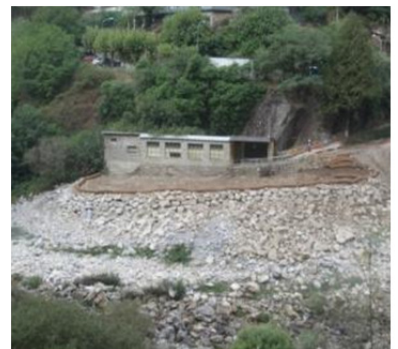
Vista de la escollera y berma de margen derecha.
