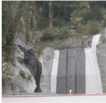
Detalle del frente que se está cubriendo con malla para proyectar sustrato con hidrosiembra.
