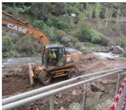
Retirada de relleno en margen derecha.
