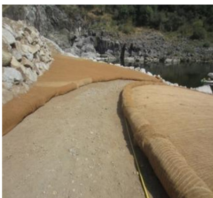
Detalle de las mantas y biorrollos dispuestos a ambos lados de la rampa de acceso al cauce.
