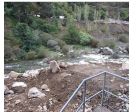
Retirada de relleno en margen derecha.
