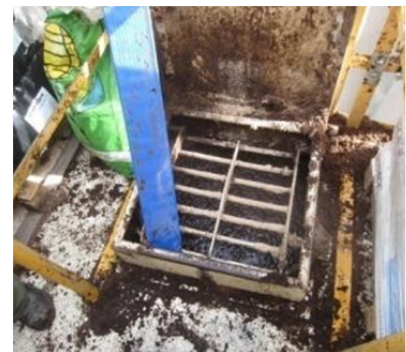
Realización mezcla de sustrato, estabilizantes, etc. para proyectar.
