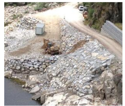
Imagen de la escollera cementada y la no cementada.
