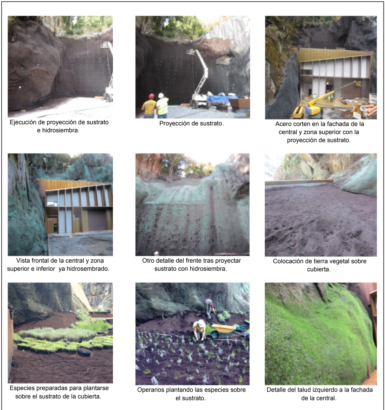
Figura 21. Trabajos de integración paisajística (Octubre 2013).
