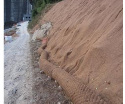
Detalle de biorrollo en la base del talud.
