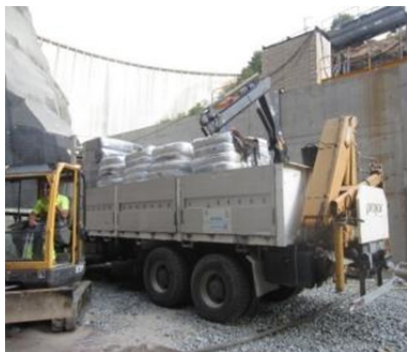
Camión que ejecuta la mezcla de sustrato y tratamiento de hidrosiembra.
