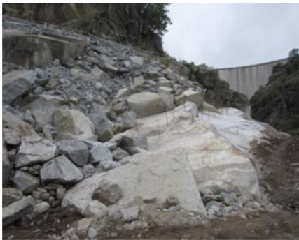
Detalle de roca madre que sirve de base de la escollera cementada.
