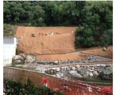
Vista frontal de la margen izquierda.
