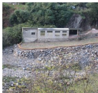
Escollera derecha y berma plantada.
