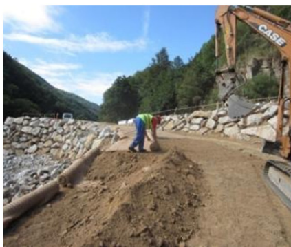
Otra vista de la maniobra de colocación de manta orgánica.
