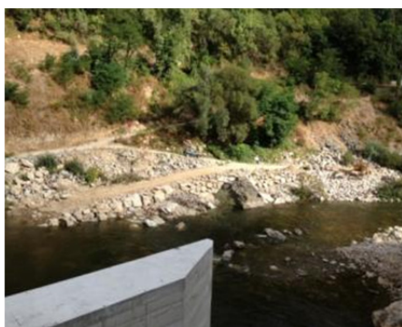
Maquinaria moviendo los bolos para escollera.
