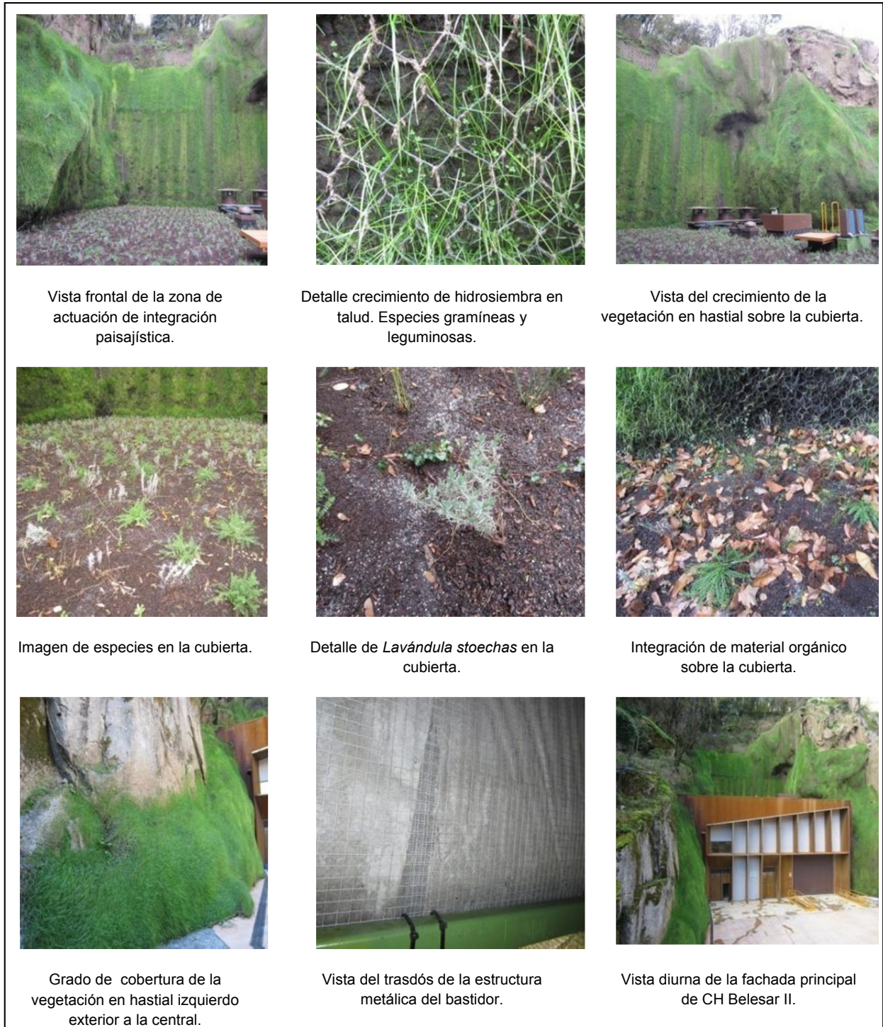
Figura 22. Trabajos de integración paisajística (Noviembre 2013)
