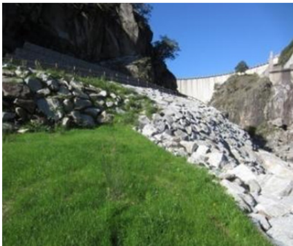
Escollera cementada y zona de crecimiento de vegetación.
