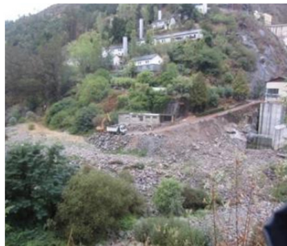
Vista desde margen izquierda del movimiento de maquinaria en margen derecha.
