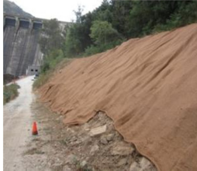
Colocación de manta orgánica en talud de margen izquierda.
