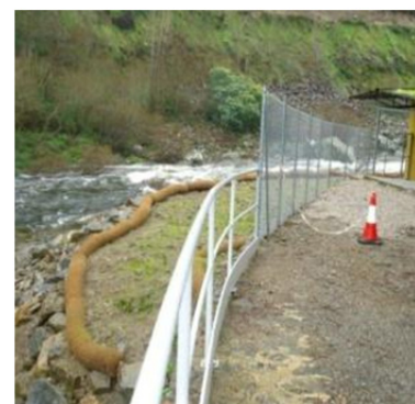
Vista de la berma de la margen derecha con las plantaciones y disposición de biorrollos.
