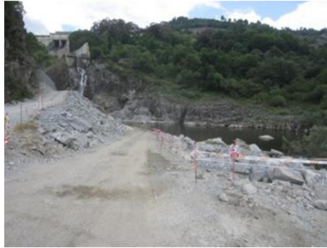
Vista aguas abajo de la berma intermedia.
