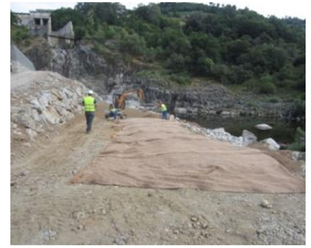
Colocación de manta orgánica.
