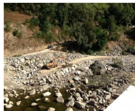
Maquinaria conformando escollera.
