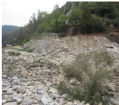
Inicio de trabajos en margen derecha para conformar escollera.
