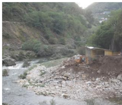
Maquinaria moviendo los bolos para escollera.
