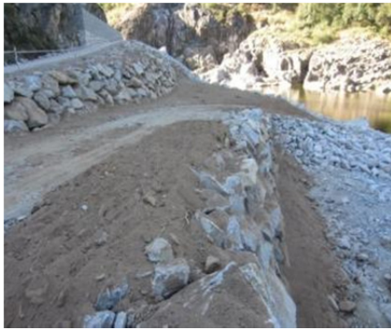
Disposición de tierra vegetal en escolleras y superficie a revegetar.
