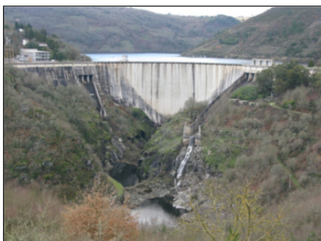
Figura 1. Presa de Belesar
