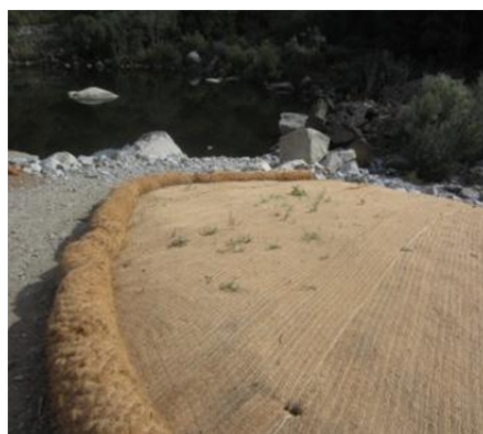
Detalle del inicio de crecimiento de especies sobre manta orgánica.
