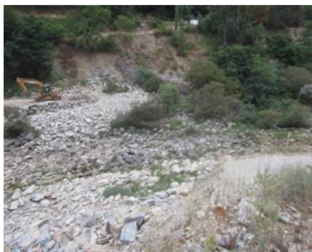
Trabajos de conformación de esquina de escollera.
