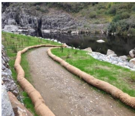
Vista de rampa de acceso y zona restaurada.
