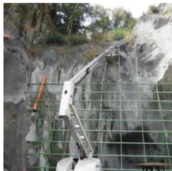
Montaje del bastidor metálico sobre el talud frontal.
