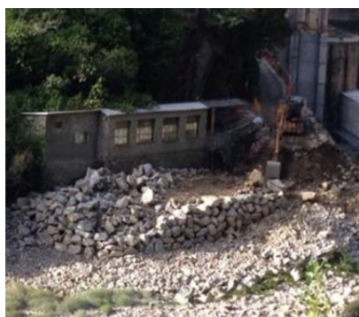
Evolución de la escollera y conformación del tacón de la misma.
