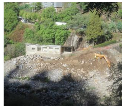
Trabajos de retirada de relleno en margen derecha.
