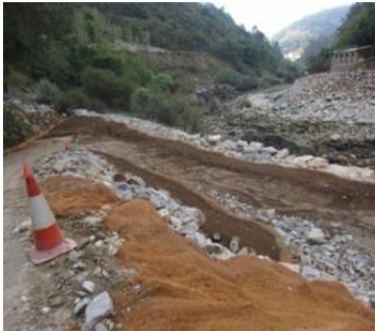
Cabeceras de las escolleras con tierra orgánica.
