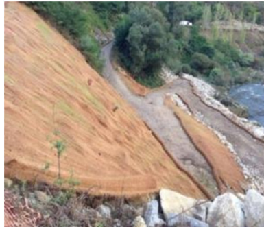
Manta orgánica y biorrollos definiendo bermas intermedias.
