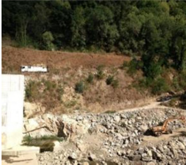
Tras el desbroce se realiza la hidrosiembra en talud.
