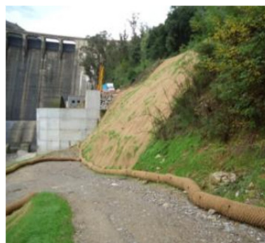
Zona de crecimiento de vegetación en talud de margen izquierda.
