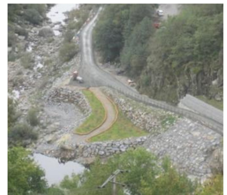
Vista desde coronación de presa de la zona de restauración.
