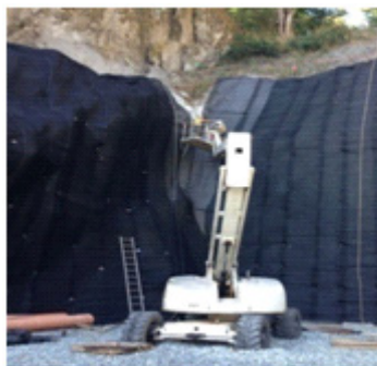
Instalación de malla triple torsión.
