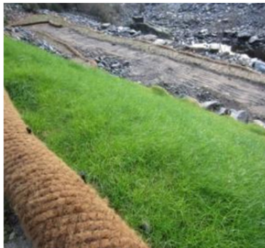
Detalle del crecimiento de hidrosiembra sobre talud de margen izquierda.
