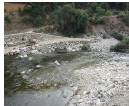
Remates en escollera y bermas intermedias.
