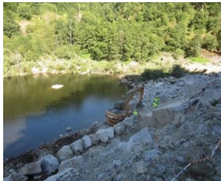
Inicio de base de escollera en el pie del talud superior de la berma intermedia.
