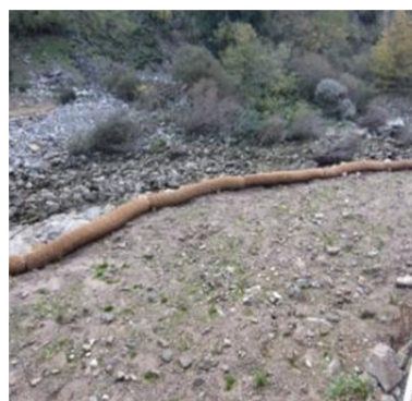
Estado actual de la plantación de la berma de la margen derecha.
