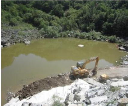
Inicio de configuración de berma intermedia.
