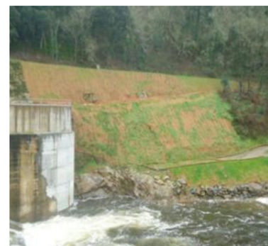
Vista frontal de la margen izquierda restaurada.
