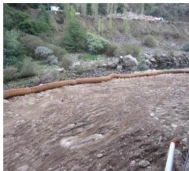
Detalle de biorrollos en cabecera de escollera de margen derecha.
