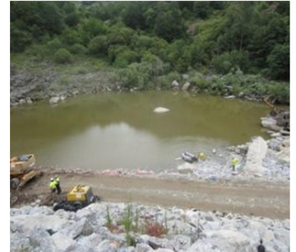
Imagen desde camino definitivo de acceso de la berma intermedia.
