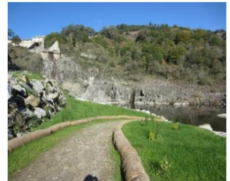
Vista de rampa de acceso y zona restaurada.
