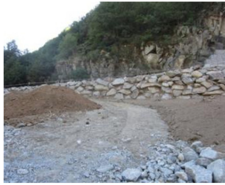
Vista desde el final de la rampa de acceso al cauce de la escollera estaquillada del talud superior. Disposición de tierra vegetal.
