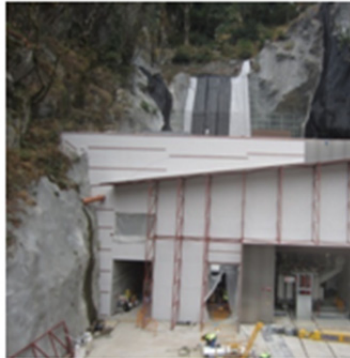
Vista frontal de la fachada de la central. Colocación planchas de acero corten y mallas volumétricas.
