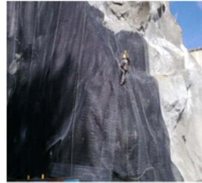
Instalación de malla triple torsión sobre mallas volumétricas.
