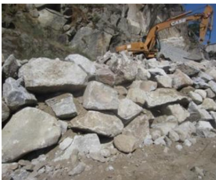
Trabajos de configuración del material rocoso para escollera estaquillada.
