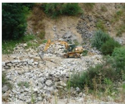
Inicio de trabajos en margen izquierda para conformar escollera.
