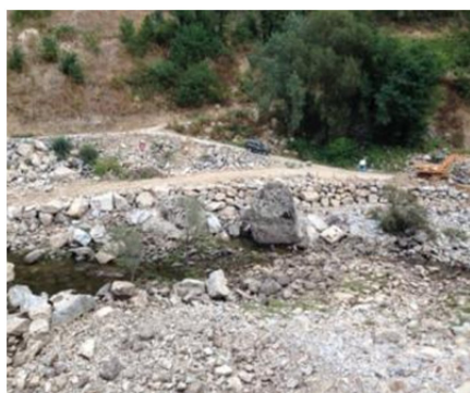
Maquinaria conformando escollera.
