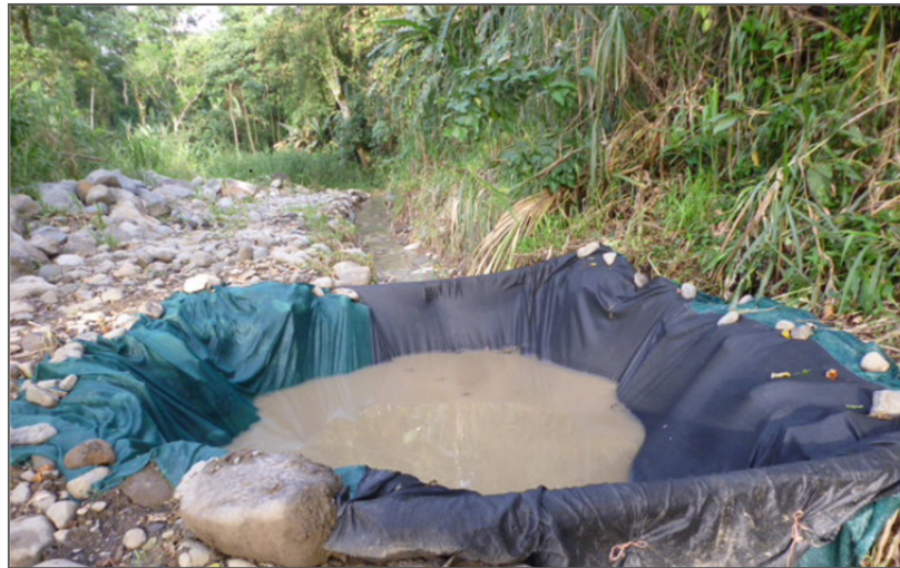
Figura 8. Trampa de sedimentos interceptando el flujo de agua contaminada
