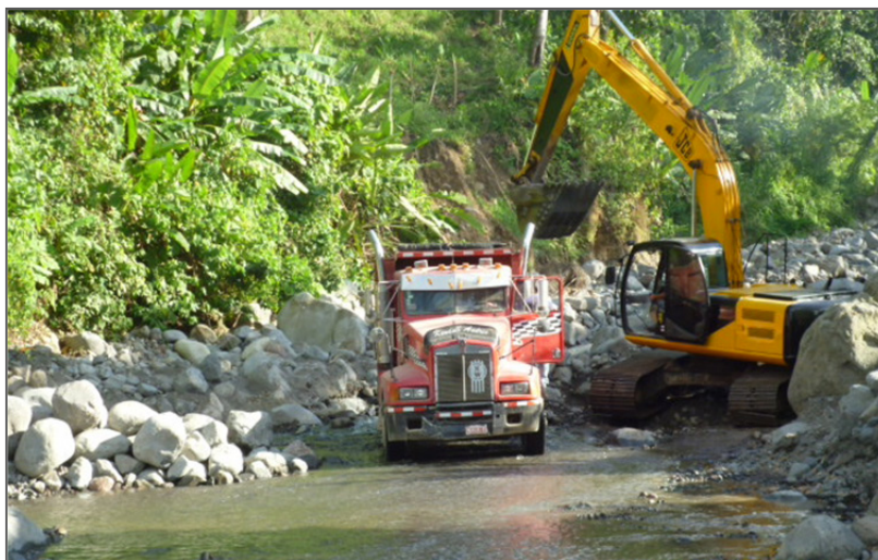
Figura 13. Maquinaria trabajando sobre el lecho del río Izarco
