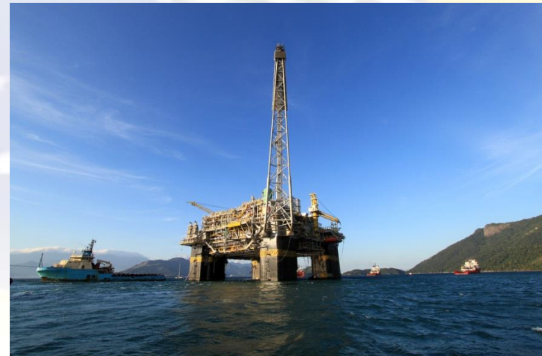
Imagen: Plataforma petrolífera en RJ (PAC2)
