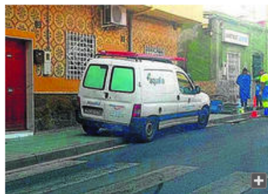
Operarios de Aqualia durante los trabajos para cortar el abastecimiento.
